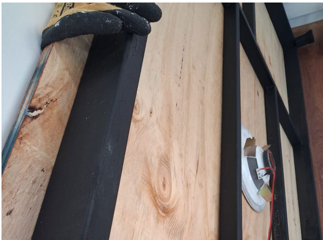
Imágenes de los parlantes adosados al piso de la plataforma
