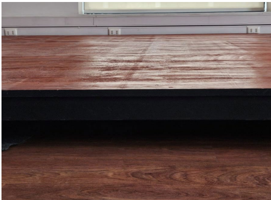
Vista de la Plataforma desde el costado. Esta construida sobre el piso existente.
